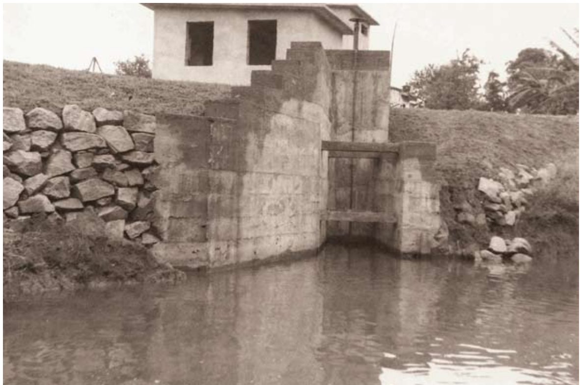
Barragem para captação de água no rio Jaguari Estação de tratamento de água
