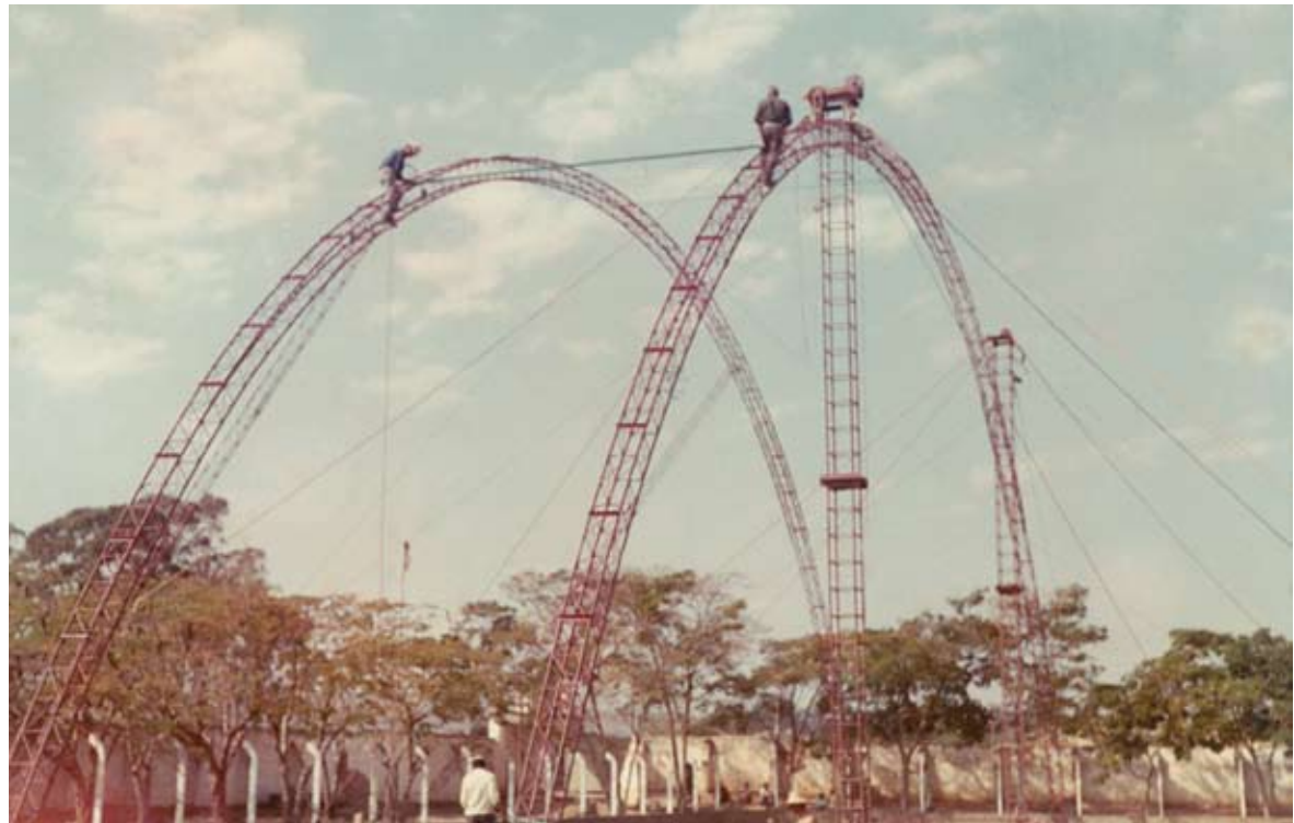
Etapas da construção do ginásio do atual Jaguar Tênis Clube
