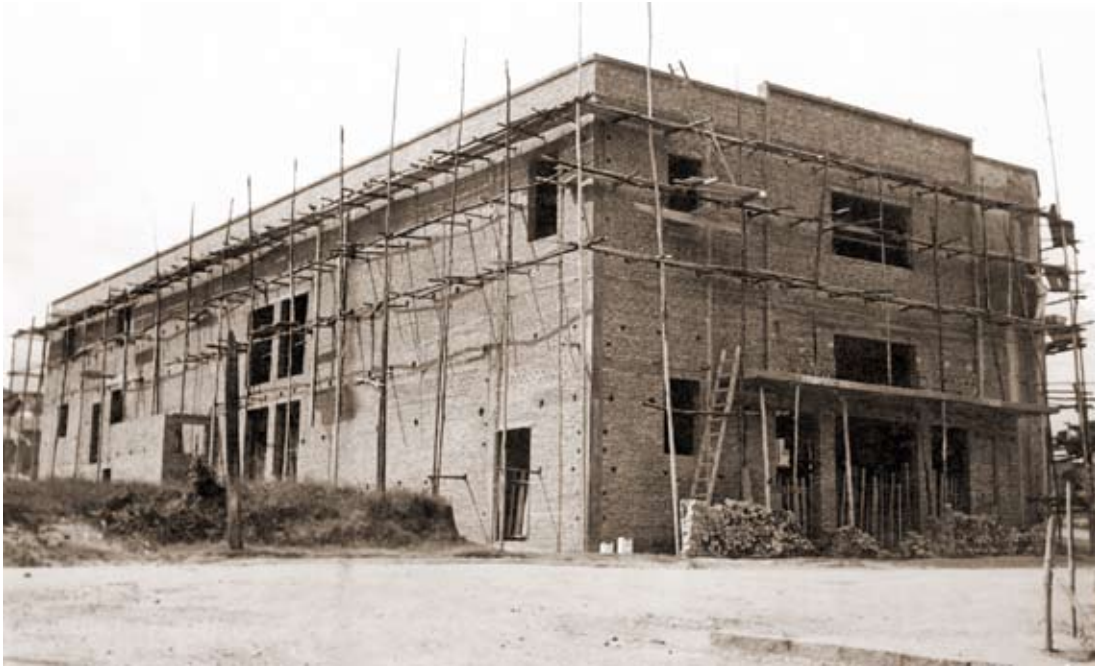
Construção do Salão Paroquial – Cine Santa Maria – (final da déc. de 50)
