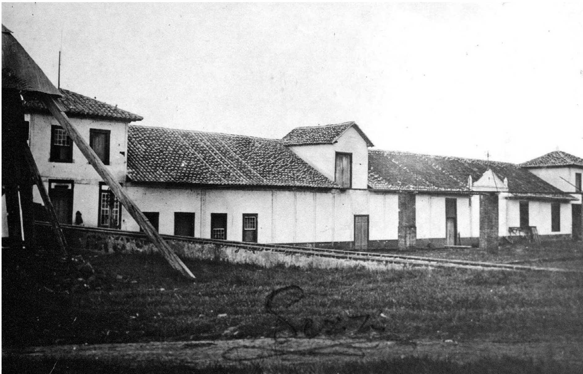
Telhados, portas e janelas, espaços em movimento em torno da produção do café. No registro, feito antes da grande enchente do rio Jaguari, vemos a trilha de café. Naquele tempo, nem os trilhos do bondinho tinham sido instalados.
